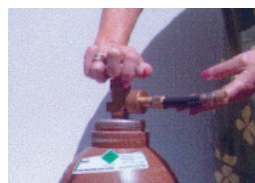
7 Handrad vom Flaschen-Absperrventil schließen
