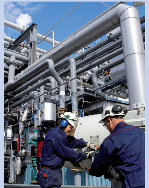
Dichtheitsprüfungen von Rohrleitungen
